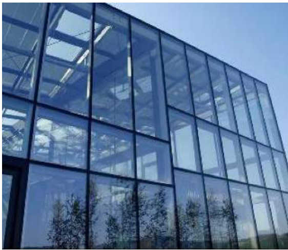
Figura 3. Edificio construido con vidrios fotovoltaicos.
