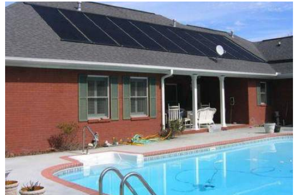
Figura 6. Casa con panel solar para calentar alberca.
