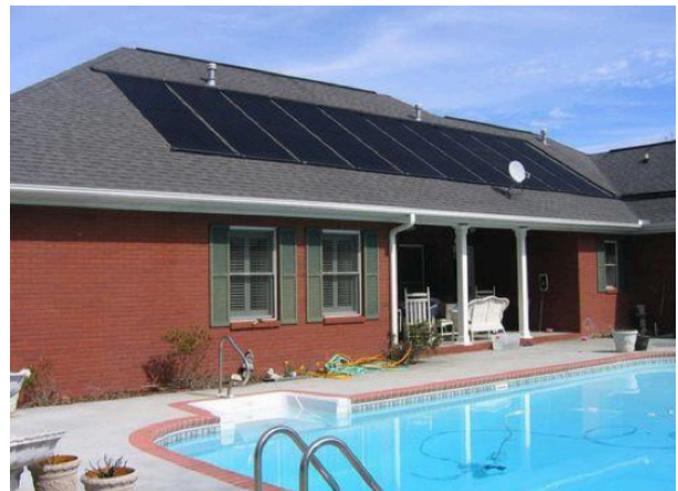
Figura 6. Casa con panel solar para calentar alberca.
