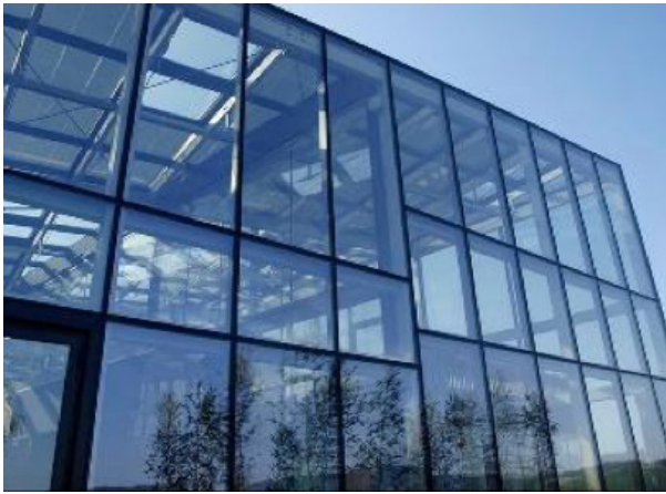
Figura 3. Edificio construido con vidrios fotovoltaicos.
