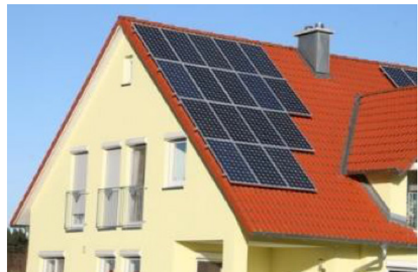
Figura 2. Casa con paneles solares.
