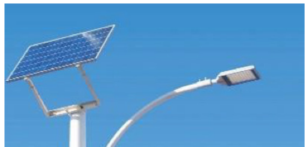
Figura 7. Lámpara que funciona con panel solar.
